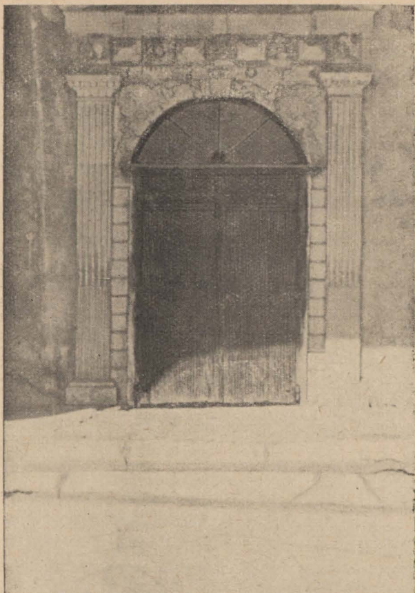
Kamienne oddrzwia drzwi wchodowych ratusza w Samborze z roku 1606. (Do strony 100).
